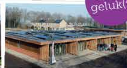
Valthermond: acht circulaire woningen aan de Vurenlaan
