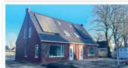
Schoonoord: zes woningen aan de Ellertstraat
